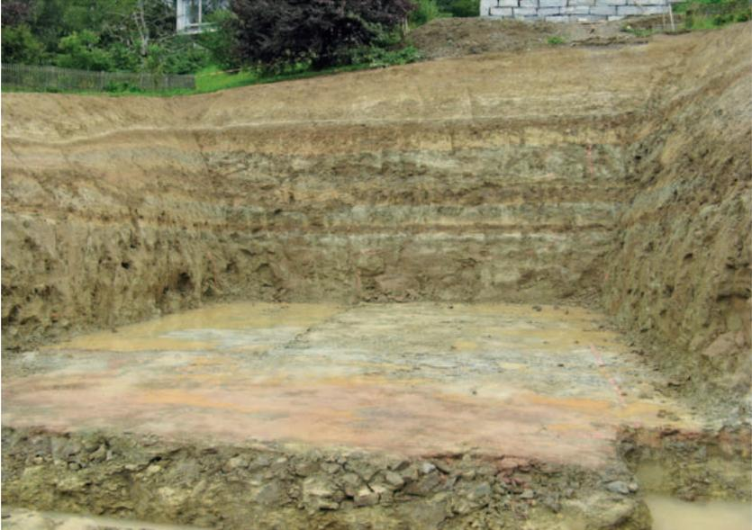
Fig. 1: Temporärer Aufschluss einer ca. 8 m breiten Baugrube in Zofingen-Bärenhubel (Koord. 638.600/238.275, 465–470 m ü. M.) mit buntem Mergel der USM («untere bunte Mergel»). Foto J. Jost, 2008.
