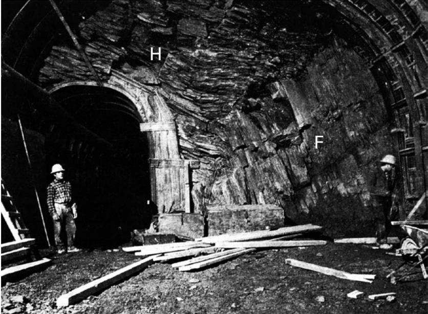
Fig. 54: Grenze zwischen stabilem Fels (F) und Fels mit Hakenwurf (H) im Riedtunnel der Gotthardautobahn (aus SCHINDLER et al. 1972, Fig. 4).
