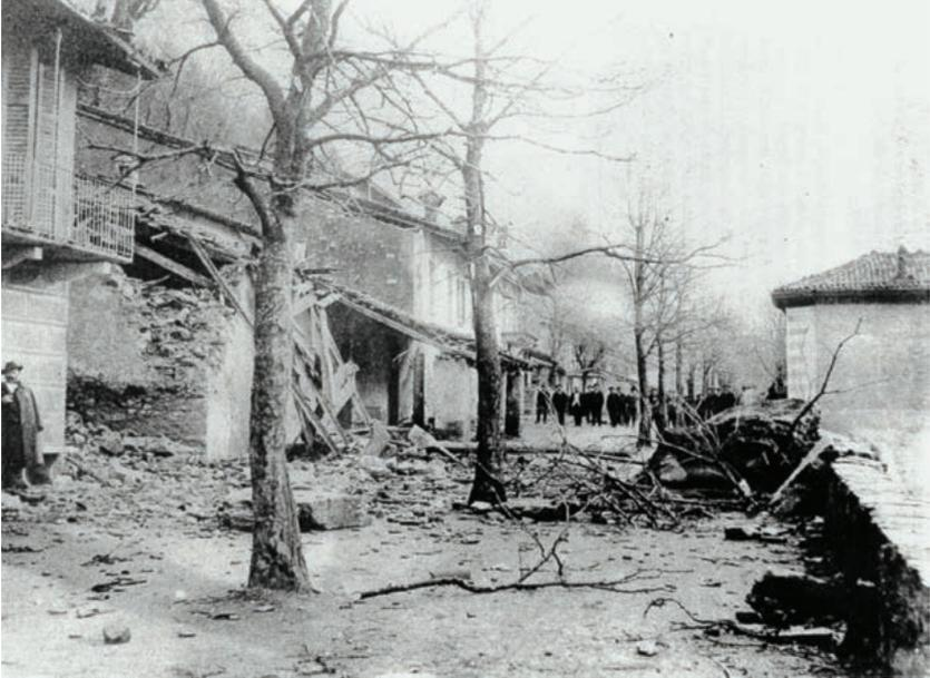
Fig. 32: Cantine di Mendrisio: caduta sassi dalla rupe di S. Nicolao con ingenti danni agli edifici. Dal 1890 in poi, con la costruzione della ferrovia del Monte Generoso, sono stati molti gli episodi di caduta sassi nella zona delle Cantine. La foto raffigura molto probabilmente l'evento del 25 febbraio 1892, l'episodio più importante che ha recato gravissimi danni a 19 cantine. Autore della foto sconosciuto. Fonte: Renato Bordogna, Osteria Lanterna, Mendrisio.
