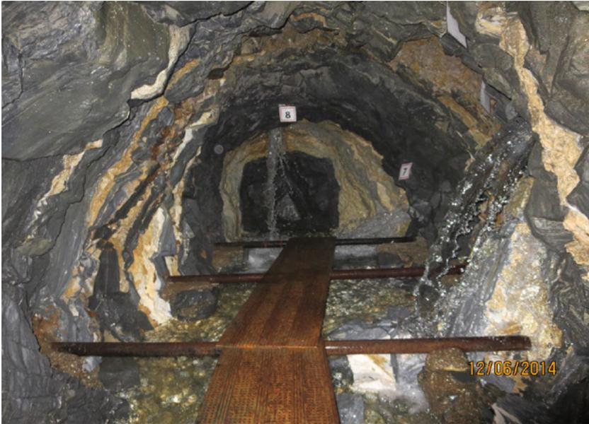
Fig. 12: Captazione principale della sorgente di Remo nelle rocce carbonatiche della Zona del Canavese. Foto Municipio di Muralto, 2014.
