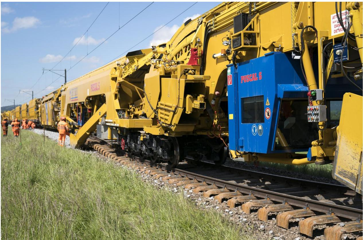
**Fig. 10:** Fahrbahnerneuerung mit einer Gleisbaumaschine: Die Schienen und Schwellen werden gehoben, der alte Gleisschotter (braun, im Vordergrund) wird ausgebaut, aufbereitet und kann als RC-Gleisschotter in Kombination mit Primärschotter wieder eingebaut werden (hellgrau, im Hintergrund).
