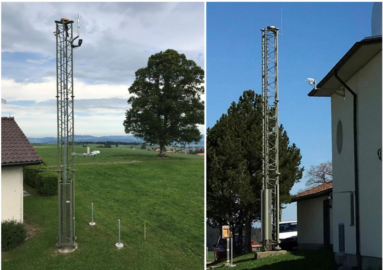
Abbildung 2-8: GNSS-Masten (ZIMM und ZIM2) [Bilder A. Wiget]
