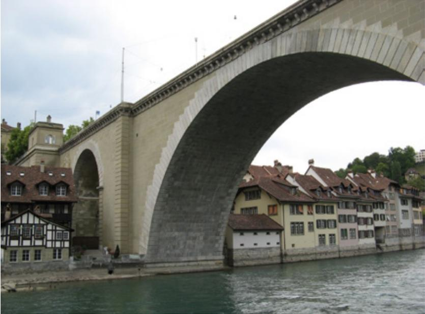
Fig. 78: Nydeggbrücke, Bern. Tragkonstruktion am grossen Bogen und Balustrade aus Findlingsgesteinen (Zentraler Aare-Granit) vom Kirchet. Foto T. Labhart.
