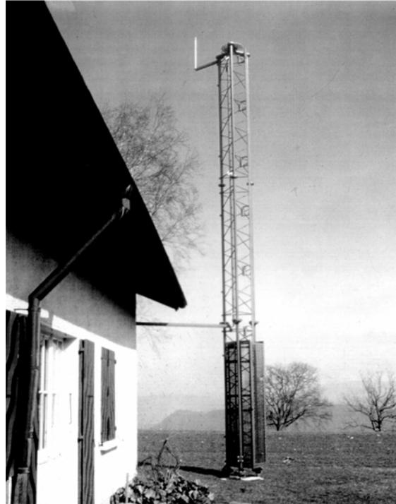
**Figure 4.3-5: Mât GPS de Zimmerwald avec cheville  $Z_0$  scellée dans le socle**
