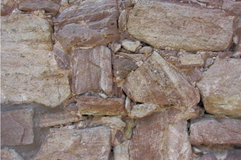
Fig. 33: Bruchsteinmauer aus «Vogesensandstein»; Hausmauer in Degerfelden. Das Material stammt aus einem der nahe gelegenen Steinbrüche in der Dinkelberg-Formation (Buntsandstein). Foto R. Burkhalter, 2019.
