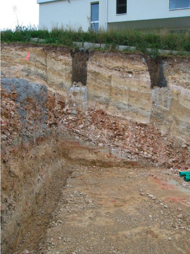
Fig. 13: Delsberg-Süßwasserkalk («Tüllingen-Schichten»), USM. Tonig-siltiger Süßwassermergel mit Einschaltung von Süßwasserkalk. Baugrube in Nushof (Koord. 2627.730/1260.365, Blick in Richtung Südosten). Foto U. Pfirter.
