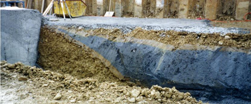
Fig. 28: Rutschmasse aus Opalinus-Ton in Schotter der Ergolz-Formation. Chienbergtunnel bei Sissach, Tagbautunnel West (Koord. 2627.890/1257.595). Foto M. Meyer, GIBS, 1999.
