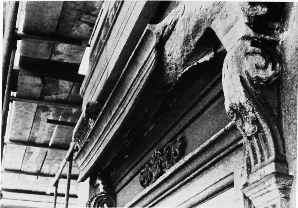
Fig. 17: Fensterverdachung mit Schale an Profilober- und Stirnseite und Gipskrusten an Profilunterseite (Granitischer Sandstein). Hauptbahnhof, W-Fassade, W-Flügel Baukörper Süd.
