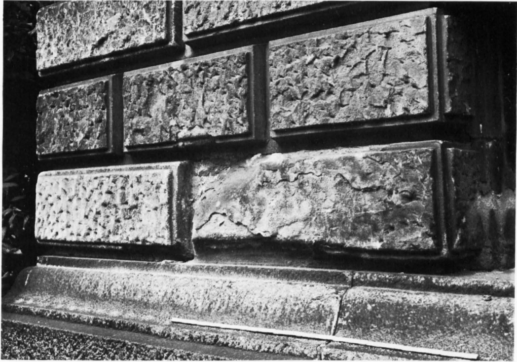
Fig. 26: Archäologisches Institut. Pyritreicher Quader aus Granitischem Sandstein zeigt lokal (Bildmitte) intensive Ausblühungen (Magnesiumsulfat und Gips) sowie starkes Absanden und Abblättern. Vom Ausblühungsherd greifen die Zerstörungen auf den oben angrenzenden Quader über.
