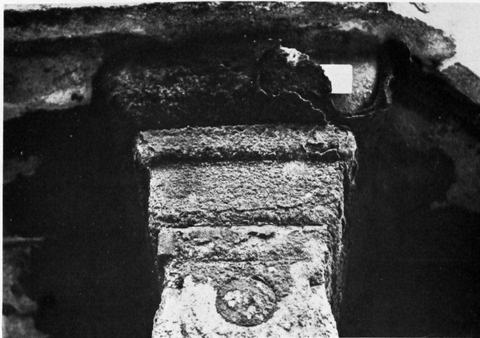
Fig. 13: Dicke, mehrfache Gipskrusten am NE-Turm, Hauptbahnhof (Probe H 14). Bildbreite 50 cm.
