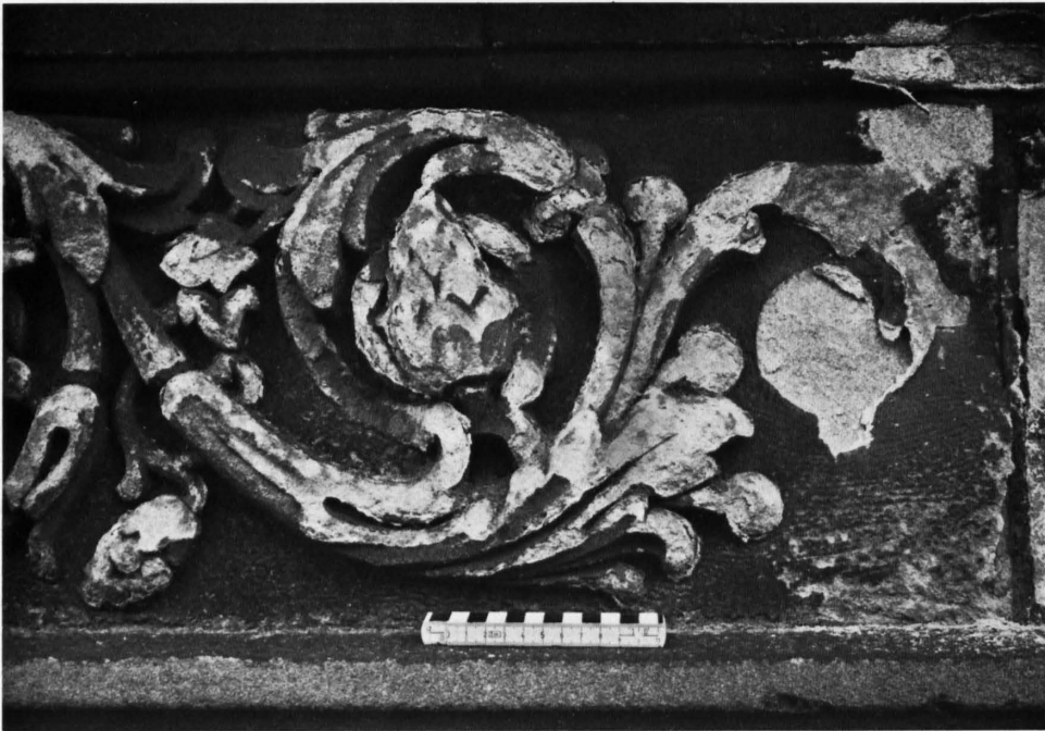
Fig. 14: Ornamente von flächenhaften Gipskrusten bedeckt, wobei vorspringende Teile abbröckeln (Granitischer Sandstein). Hauptbahnhof, unterhalb Dachgesims S-Fassade Baukörper Süd.
