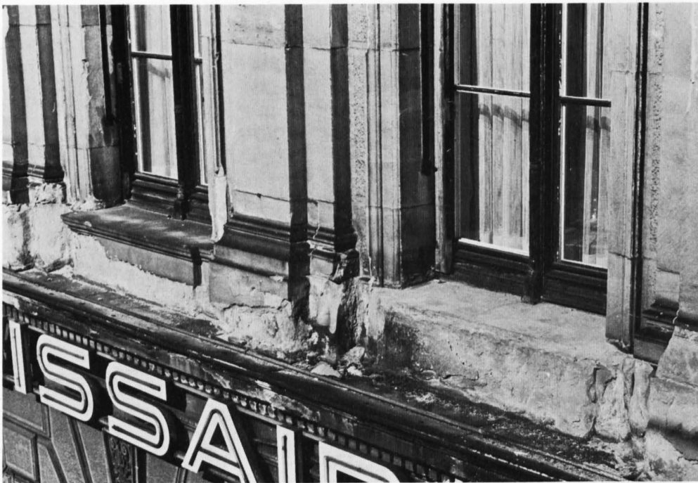
Fig. 15: Hauptbahnhof, Ausschnitt aus der S-Fassade. Fensterbrüstung über Gurtgesims, auf dem Wasser stagniert, stark abbröckelnd und schalenbildend (Granitischer Sandstein).
