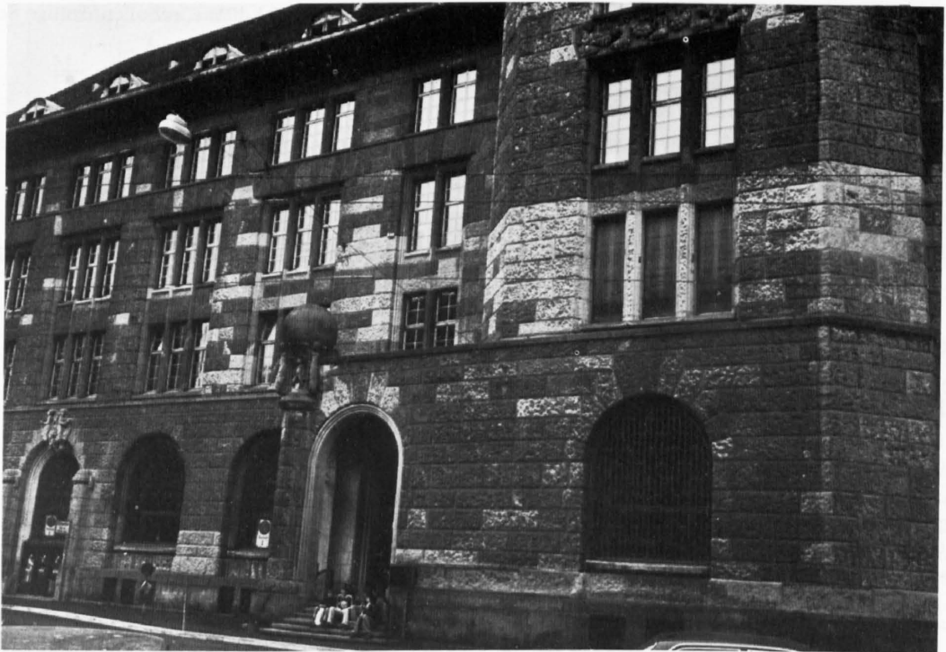
Fig. 19: Ausschnitt aus der N-Fassade der Hauptpost: helle, stark absandende Quader sind unregelmässig in der generell dunklen, krustenbedeckten Mauerfläche verteilt.
