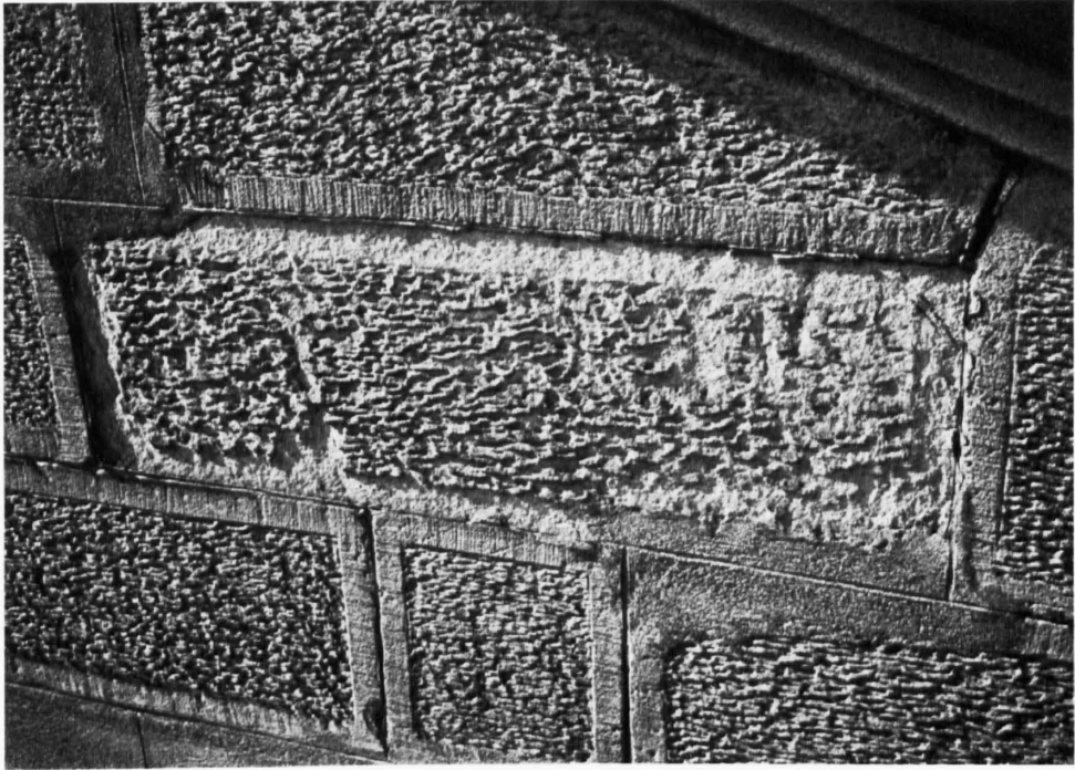
Fig. 9: Quader (Granitischer Sandstein) mit absandenden Vertiefungen und als "Schalen" abfallenden Höckern der Bearbeitung. Kanten im Bereich der (harten) Zementfugen abgesplittert. Bildbreite 1 m. (Hauptbahnhof, N-Fassade der Aufnahmehalle oberhalb Dachbalustrade).
