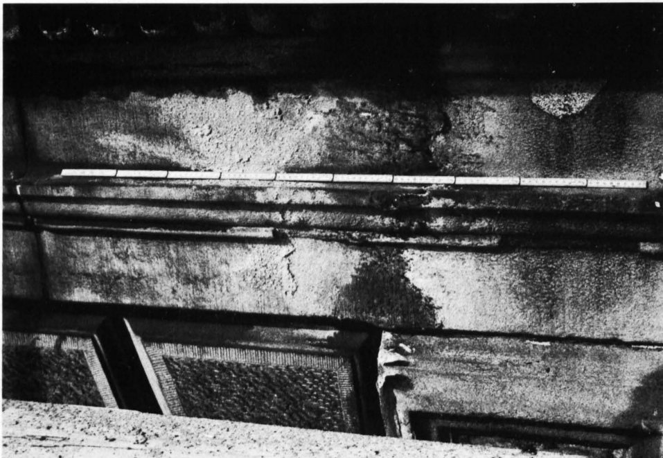
Fig. 12: Oberflächliche Sickerwasserstelle in regengeschütztem Bereich (E-Fassade des Hauptbahnhofes). Überspülte Zone (rechts) nach aussen (links) übergehend in krustenbedeckte (dunkel) und stark absandende (hell) Zone mit Ausblühungen. Skala 1 m.
