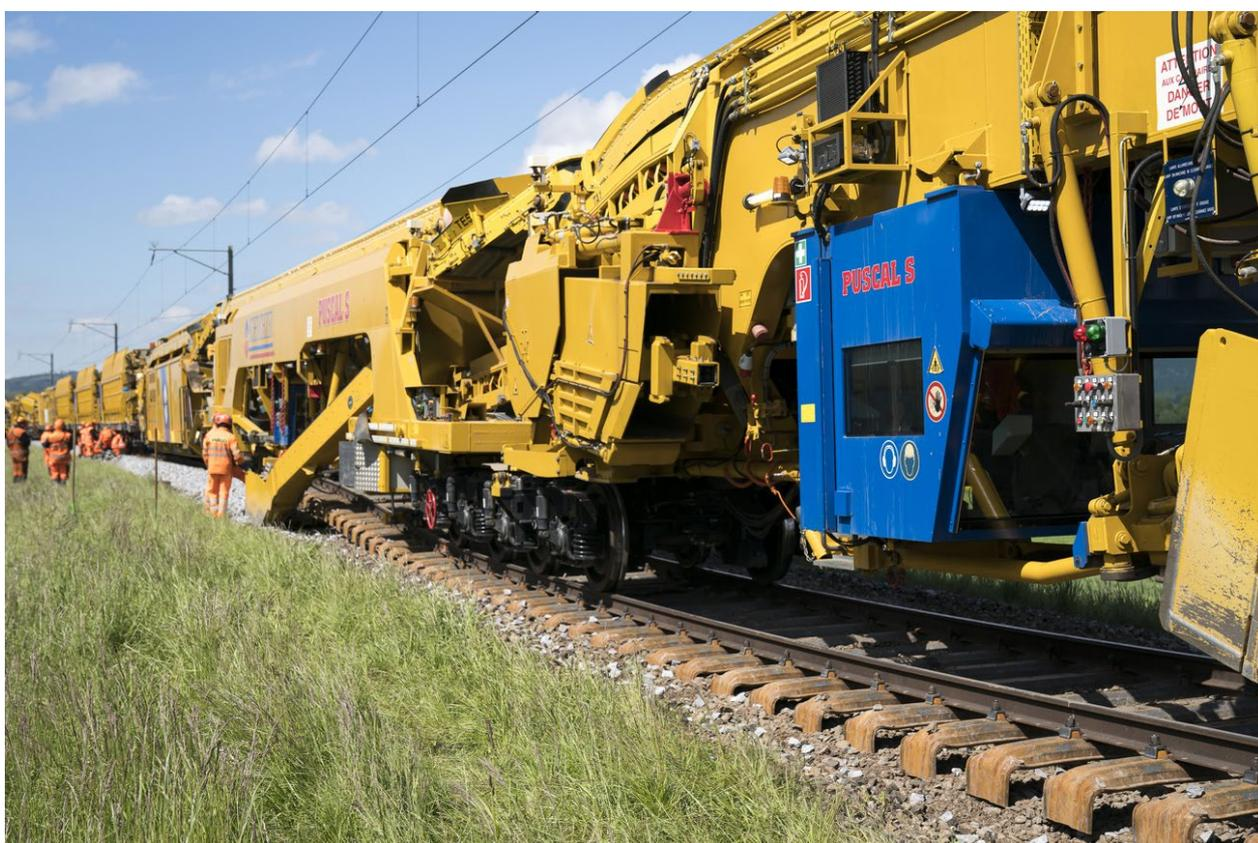
**Fig. 10:** Réfection de voie avec un train d'assainissement: Les rails et les traverses sont soulevés, le ballast ferroviaire ancien (brun, à l'avant-plan) est retiré et criblé, puis il peut être reposé comme ballast RC en combinaison avec du ballast ferroviaire primaire (gris clair, à l'arrière-plan).
